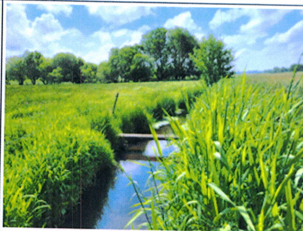
Photos n°6 : vue intermédiaire des travaux ruisseau de la Marguerite
